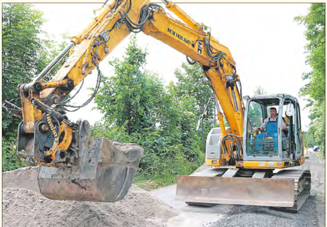
Im Ammelshainer Weg in Waldsteinberg baut der AZV Parthe momentan Schmutzwasserkanäle und Schmutzwasserdruckleitungen. Ausführende Firma ist die Dahlemer Bau GmbH.
